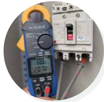
電気設備工事
