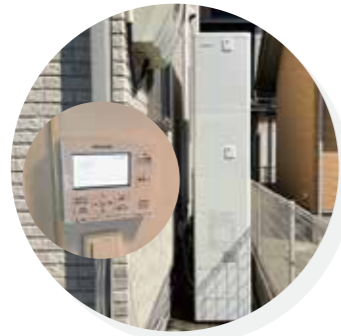
住宅設備工事
