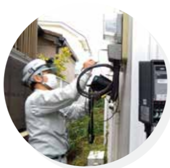
EV充電器設備工事
